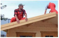
Bringen Sie nun die Giebelbretter vorn und hinten an. Befestigen Sie die Giebelbretter mit Schrauben an der Dachschalung und der First-/Mittelpfette, der Abstand von Oberkante Giebelbrett zu Oberkante Dachschalung sollte ca. 5 - 6 cm betragen. (Eine Hilfe ist es, wenn Sie an der Firstpfette die Mitte mit einem Bleistiftstrich markieren. So kommen Sie nicht ungewollt über die Mitte der Firstpfette.)
