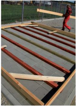
Wenn alles passt, nehmen Sie ein paar Holzreste aus dem Paket und verschrauben diese in zwei Ecken mit den Lagerhölzern. Diese verhindern, dass sich der Rahmen verschiebt.
