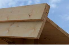
Montieren Sie die Traufbretter mit Schrauben an der Dachschalung. Achten Sie darauf, dass die Oberkante des Brettes nicht über die Dachschalung ragt.
