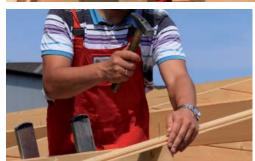
Beginnen Sie an der Vorderseite und richten Sie das erste Brett vorne bündig mit der First-/Mittelpfette und der Traufbohle aus. Beachten Sie hierbei. dass Sie das Brett exakt an der Mitte der Firstpfette ausrichten. Dies ist nötig, um einen Holzüberstand am First zu vermeiden, der das Anbringen der gegenüberliegenden Bretter verhindern würde.
