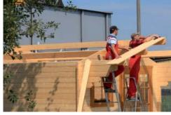
Nageln Sie nun die Bretter jeweils an der Firstpfette, Mittelpfette und an der Traufbohle zweimal fest. Verlegen Sie anschließend die Dachschalung bis nach hinten durch. Messen Sie in regelmäßigen Abständen nach, dass die Bretter in einer Flucht liegen und dass die Abstände zur Wand gleichmäßig sind. Das hinterste (letzte) Brett muss in den meisten Fällen auf Maß geschnitten werden.
