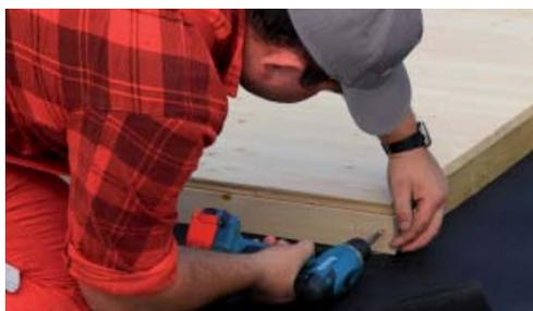
Befestigen Sie die beiden fehlenden Blenden des Bodens mit Hilfe eines Akkuschraubers und des mitgelieferten Schraubensets.
