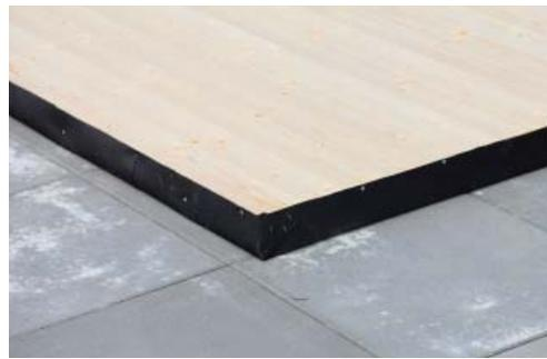
Dachpappe schützen wollen, so ziehen Sie das überstehende Material hoch und befestigen Sie es mit kleinen Nägeln oder Klammern an den Blenden des Bodens. Das überstehende Material wird mit einem Cuttermesser abgeschnitten.
