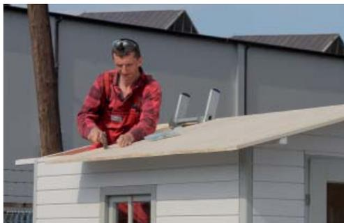
Beginnen Sie an der Vorderseite und richten Sie das erste Brett vorne bündig mit der Firstpfette/Traubohle aus. Beachten Sie hierbei, dass Sie das Brett exakt an der Mitte der Firstpfette ausrichten. Dies ist nötig, um einen Holzüberstand am First zu vermeiden, der das Anbringen der gegenüberliegenden Bretter verhindern würde.
