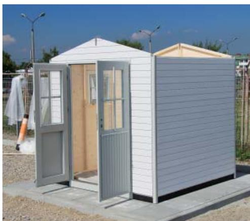
Prüfen Sie nun, ob die Elemente richtig auf dem Boden sitzen. Gegebenenfalls korrigieren Sie diese durch Drücken der Elemente nach, bis sie passen. Verschrauben Sie nun die Elemente ausreichend mit dem Boden und kontrollieren Sie nochmals, ob Sie die Wandteile untereinander auch ausreichend verschraubt haben.
