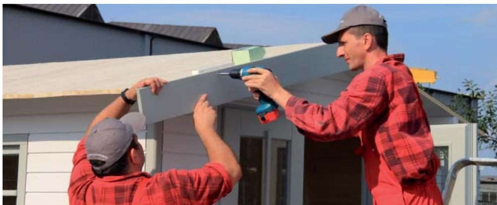
Nageln Sie nun die Bretter jeweils an der Firstpfette und an der Traufbohle zweimal fest. Verlegen Sie nun die Dachschalung bis nach hinten durch. Messen Sie in regelmäßigen Abständen nach, dass sie in einer Flucht liegen und dass die Abstände zur Wand gleichmäßig sind. Das hinterste Brett muss in den meisten Fällen auf Maß geschnitten werden. Im Anschluss bringen Sie die andere Hälfte der Schalung wie bereits vorher beschrieben an.
