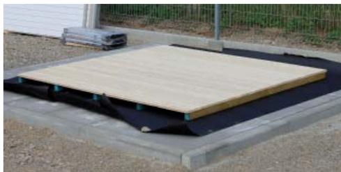
Legen Sie den vormontierten Boden an die von Ihnen gewünschte Position auf das Fundament.
