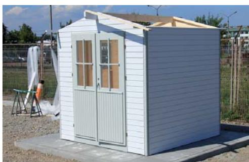
Achten Sie darauf, dass der Abstand bei allen eingesetzten Brettern gleich ist. Im nächsten Schritt bringen Sie die Dachschalung an.
