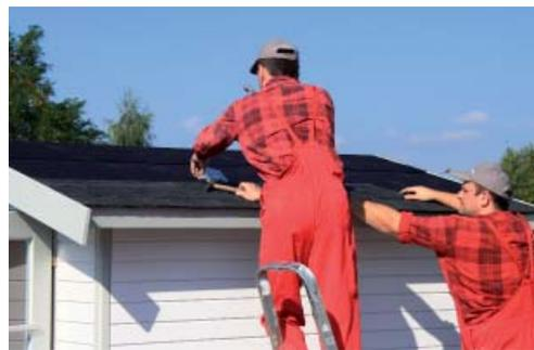
Verlegen Sie die Bahnen so, dass die nächsten Lagen immer ca. 20 - 30 cm über die darunterliegende Bahn am oberen Rand überlappt.
