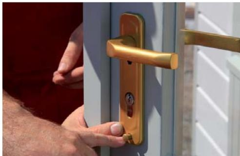
Stecken Sie den Fenstergriff in das am Fenster verbaute Schloss. Sie können die oberste Schraube mit einem Akkuschauber oder einem Schraubendreher eindrehen. **Achten Sie darauf, dass Sie diese nicht überdrehen, falls sie mit einem Akkuschauber arbeiten.**
