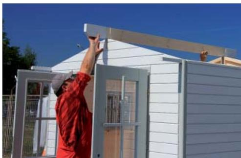
Nun setzen Sie die Firstpfette in die dafür vorgefertigten Ausschnitte. Bringen Sie die beiden Traufleisten links und rechts vom Giebel mit an.
