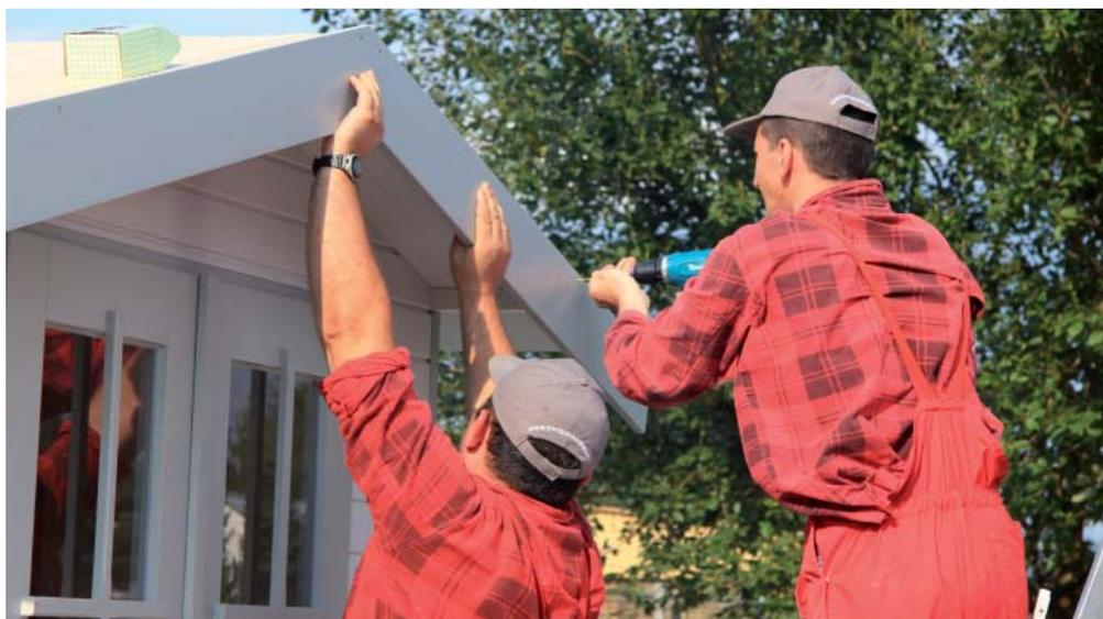
Bringen Sie nun die Giebelbretter vorn und hinten an. Befestigen Sie die Giebelbretter mit Schrauben an der Dachschalung und der Firstpfette, der Abstand von Oberkanten Giebelbrett zu Oberkanten Dachschalung sollte ca. 5 - 6 cm betragen. Eine Hilfe ist es, wenn Sie an der Firstpfette die Mitte mit einem Bleistiftstrich markieren. So kommen Sie nicht ungewollt über die Mitte der Firstpfette.
