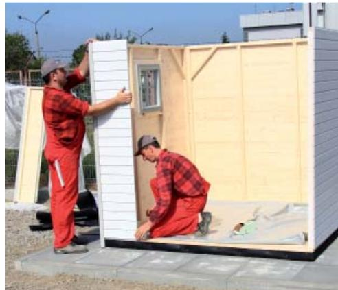
Stellen Sie nun nach und nach alle Wandteile an die Stelle, wie sie im Plan verzeichnet sind. Verschrauben Sie die Wandelemente mind. 4 mal pro Seite (oben, unten und zwei Mal in der Mitte mit entsprechendem Abstand).
