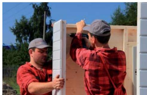
Die Elemente müssen spaltfrei und bündig miteinander verschraubt werden. Es empfiehlt sich, Schraubzwingen als Hilfsmittel zur Fixierung der Elemente untereinander zu verwenden.
