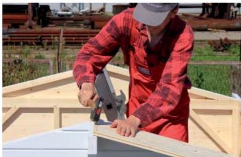
Die Dachschalung ist bereits auf die richtige Länge geschnitten, so dass Sie die Bretter nur noch von vorne nach hinten verlegen müssen.
