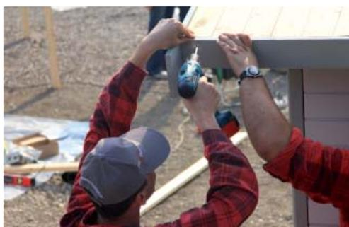
Montieren Sie die Traufbretter mit Schrauben an der Dachschalung. **Achten Sie darauf, dass die Oberkante des Brettes nicht über die Dachschalung ragt.**
