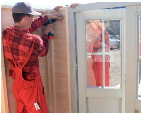
Stecken Sie den von der Seite entfernten Schlüssel in den Schließzylinder und prüfen Sie, ob dieser richtig sperrt. Setzen Sie die Tür nun in das Haus ein. Öffnen Sie die Türe und korrigieren Sie die Türe gegebenenfalls auch mit von innen. **Achten Sie darauf, dass der Türflügel nicht unkontrolliert aufschlägt.** Schrauben Sie die Türe nun mit den Elementen fest und sorgen Sie dafür, dass diese exakt eingebaut ist.
